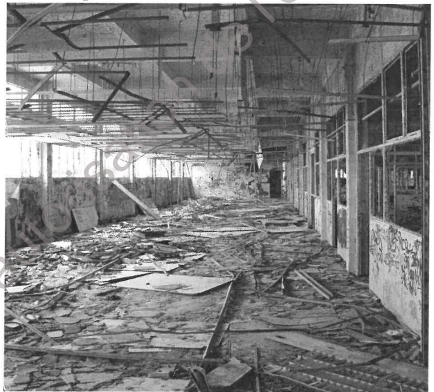
Locaux à l'abandon (photo J-P Desthuiliers)
