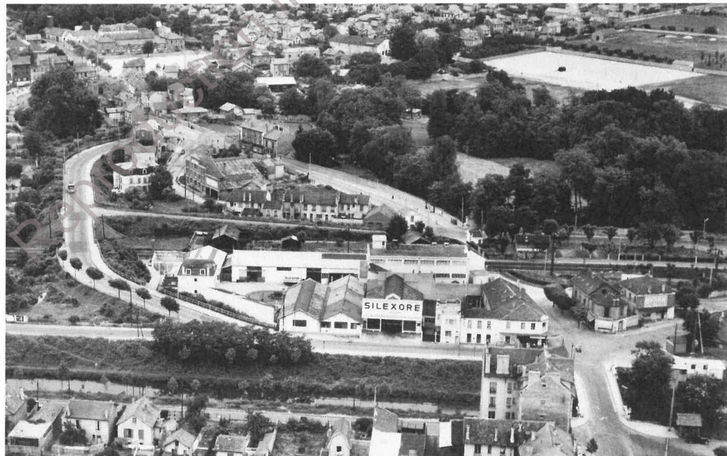
Vue aérienne de l'usine Silexore, (collection particulière)
