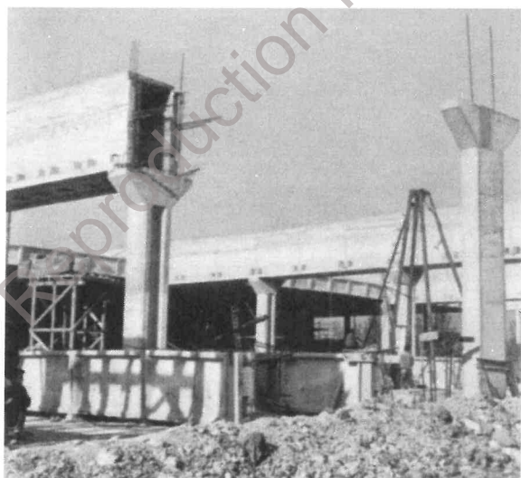
1957 - Construction du bâtiment 23
