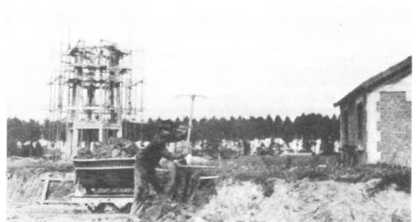
La base du château d'eau et le pavillon d'entrée
