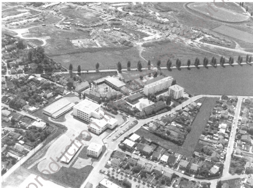
Vue du nord des Sablons en chantier vers 1978.
