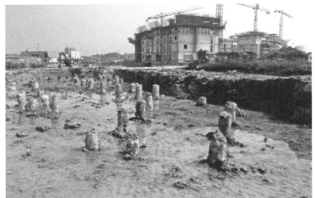
Les Beaudottes en chantier vers 1984.
