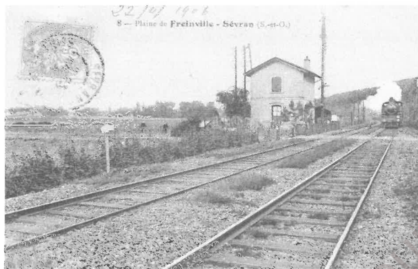
Le passage à niveau reliant Rougemont à Freinville.
