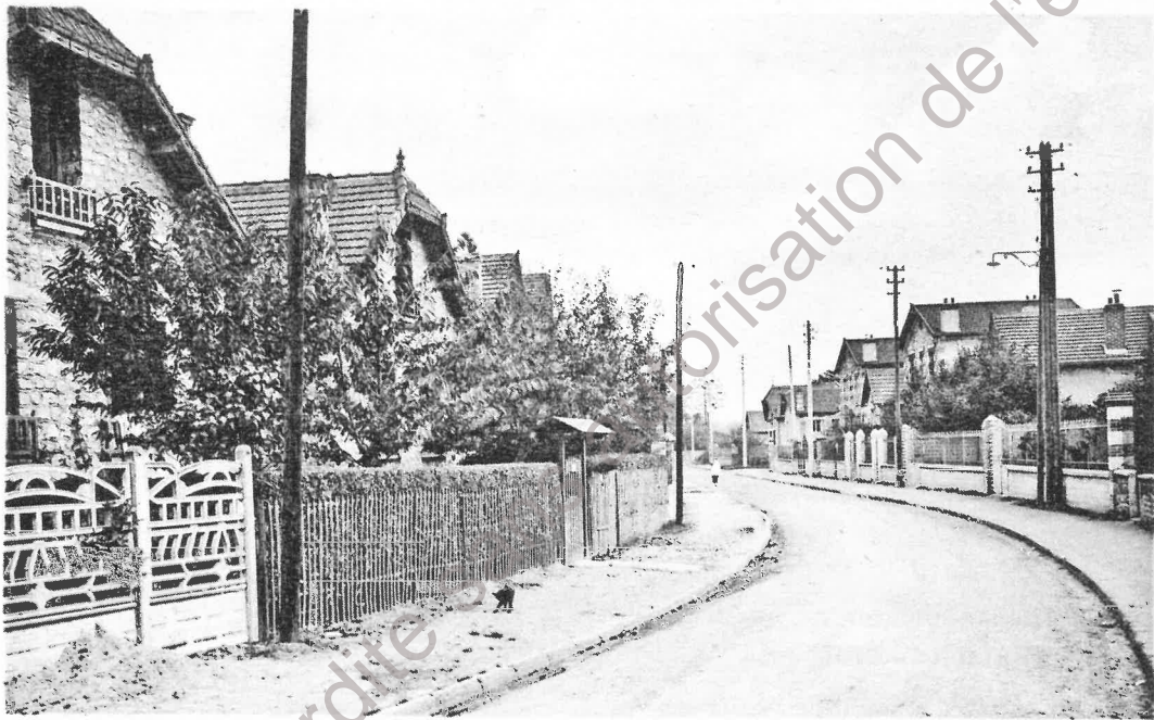
2. - SEVRAN (S-et O.) — Lotissement de la Mairie
