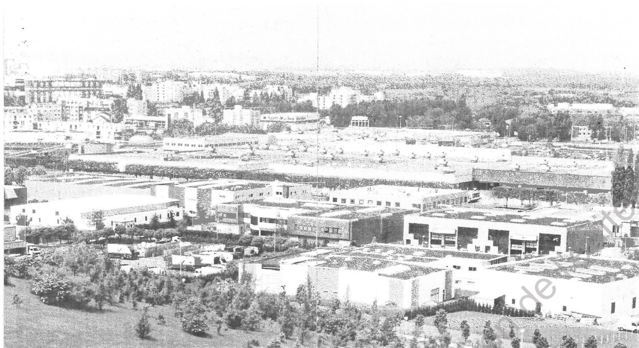
La zone commerciale des années 70 entre le Gros Saule à Aulnay-sous-bois et la zone d'activité des années 80.
